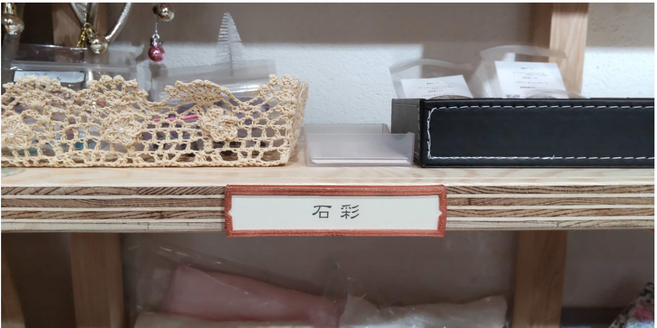
⑩屋号プレート枠(塗装・取り付け)
